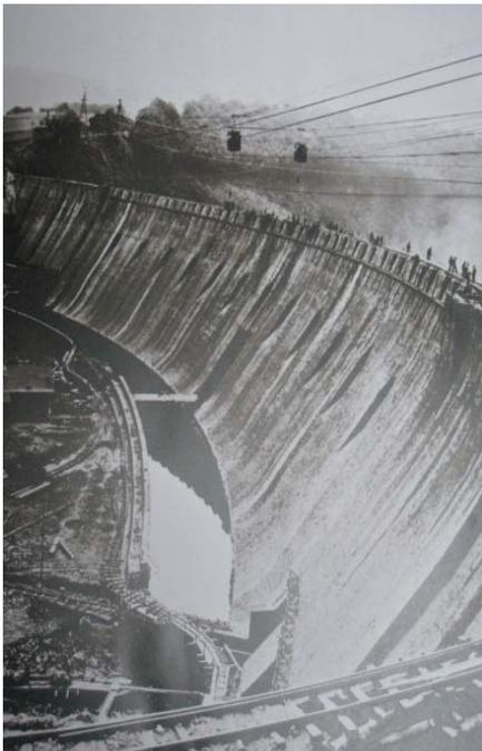
Die Edertalsperre wurde in den Jahren 1908 bis 1914 von der Fa. Philipp Holzmann AG gebaut. Beim Bau der Sperrmauer wurden 300.000 Kubikmeter Bruchstein vermauert. Der Bau incl. Grunderwerb kostete 25 Mio. Goldmark (entspricht ca. 122 Mio. Euro).
